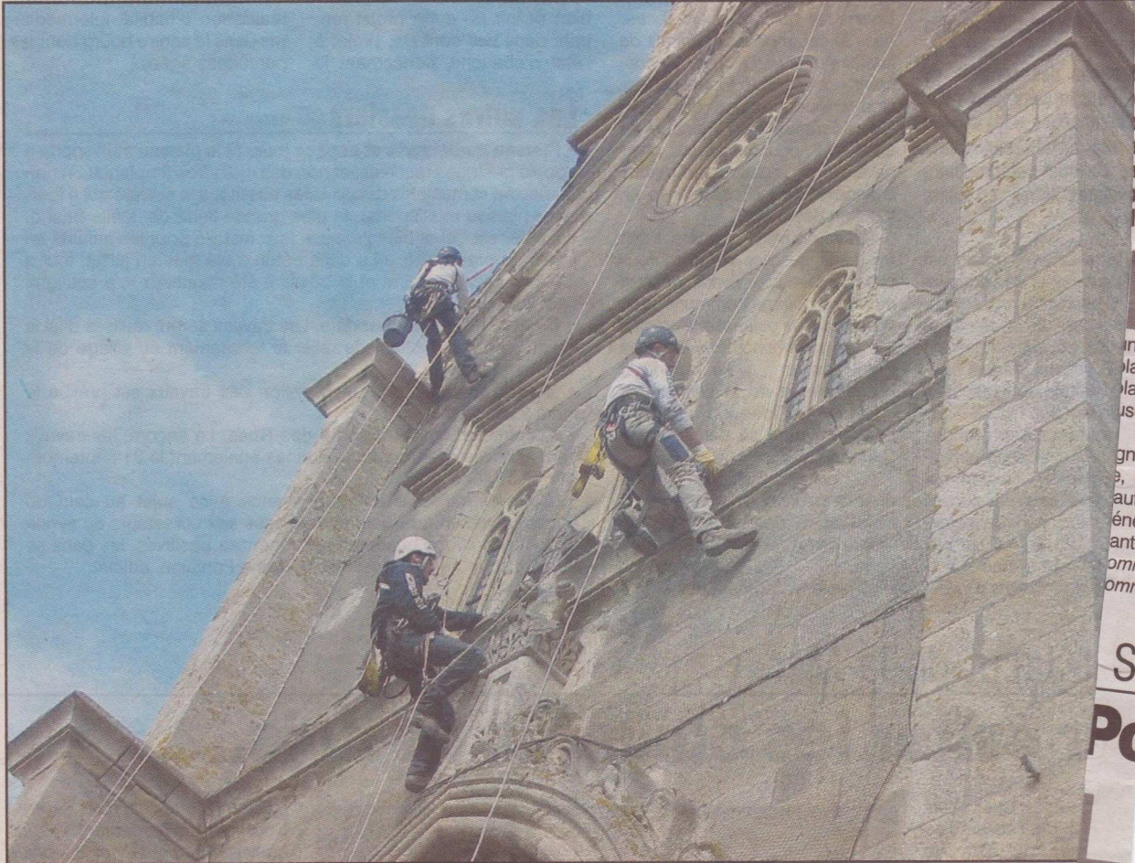
Les alpinistes du bâtiment qui ont reçu une formation très spécifique sont intervenus sur la façade de l'église.
